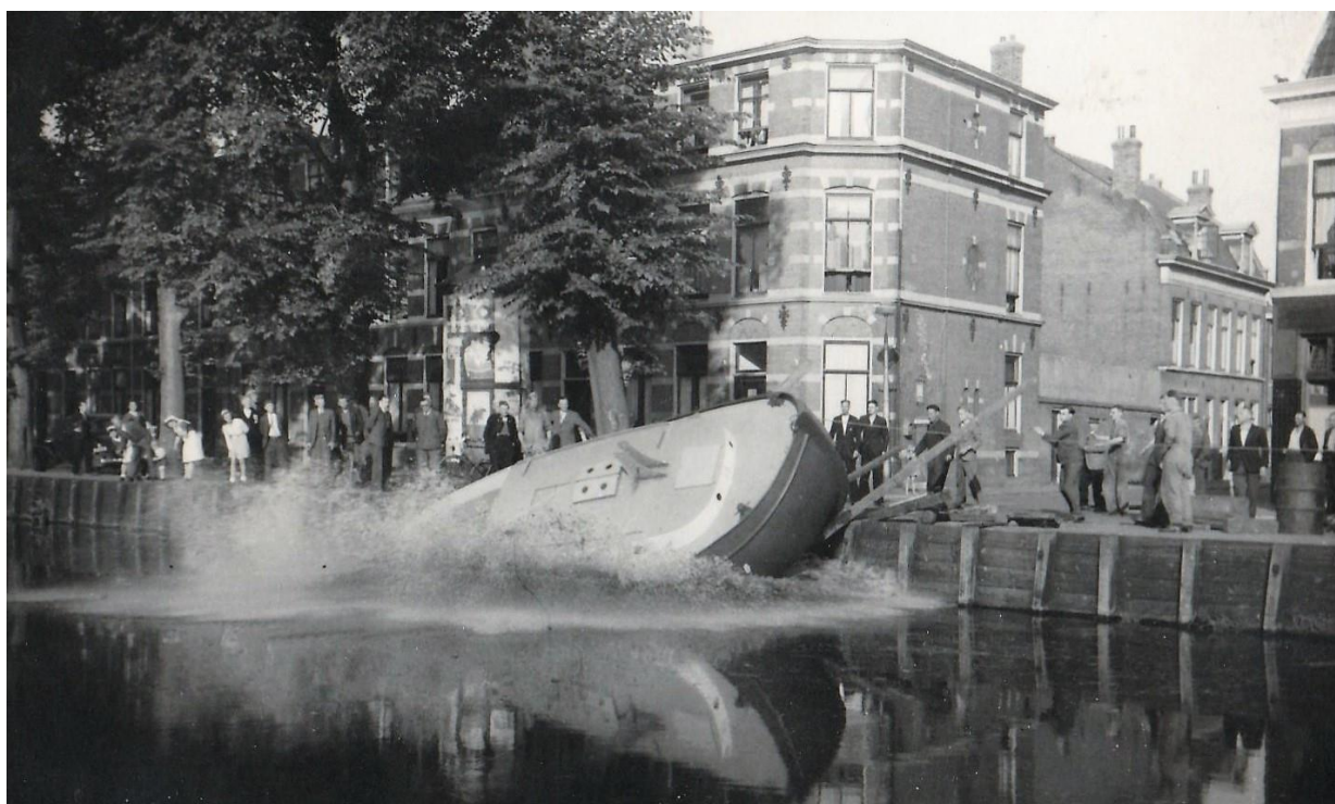
Haarlem, 1947. De loodgieter De Graaf heeft zijn zelfgebouwde jol naar het water getransporteerd en laat die te water.
