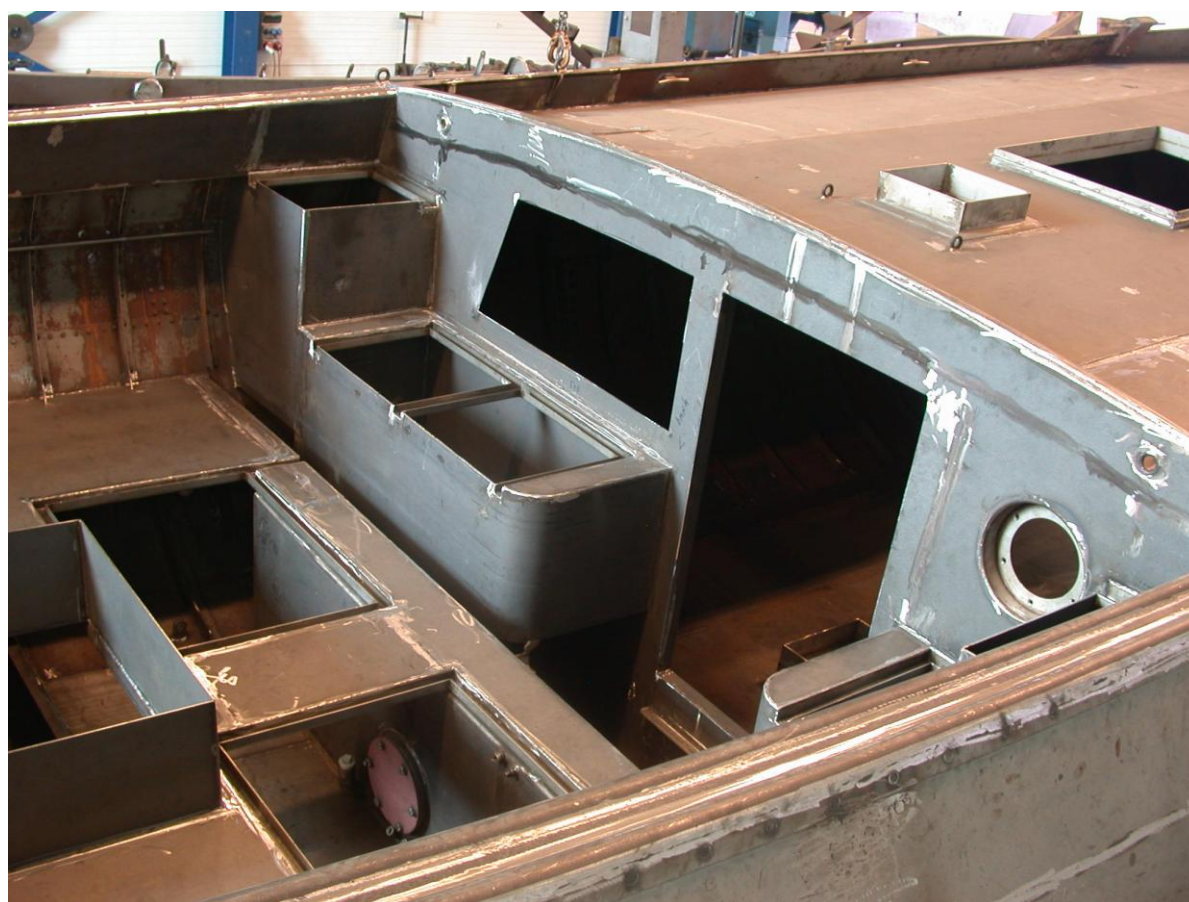
Na herstel van de romp is een nieuw dek aangebracht en wordt de kuip ingericht.
