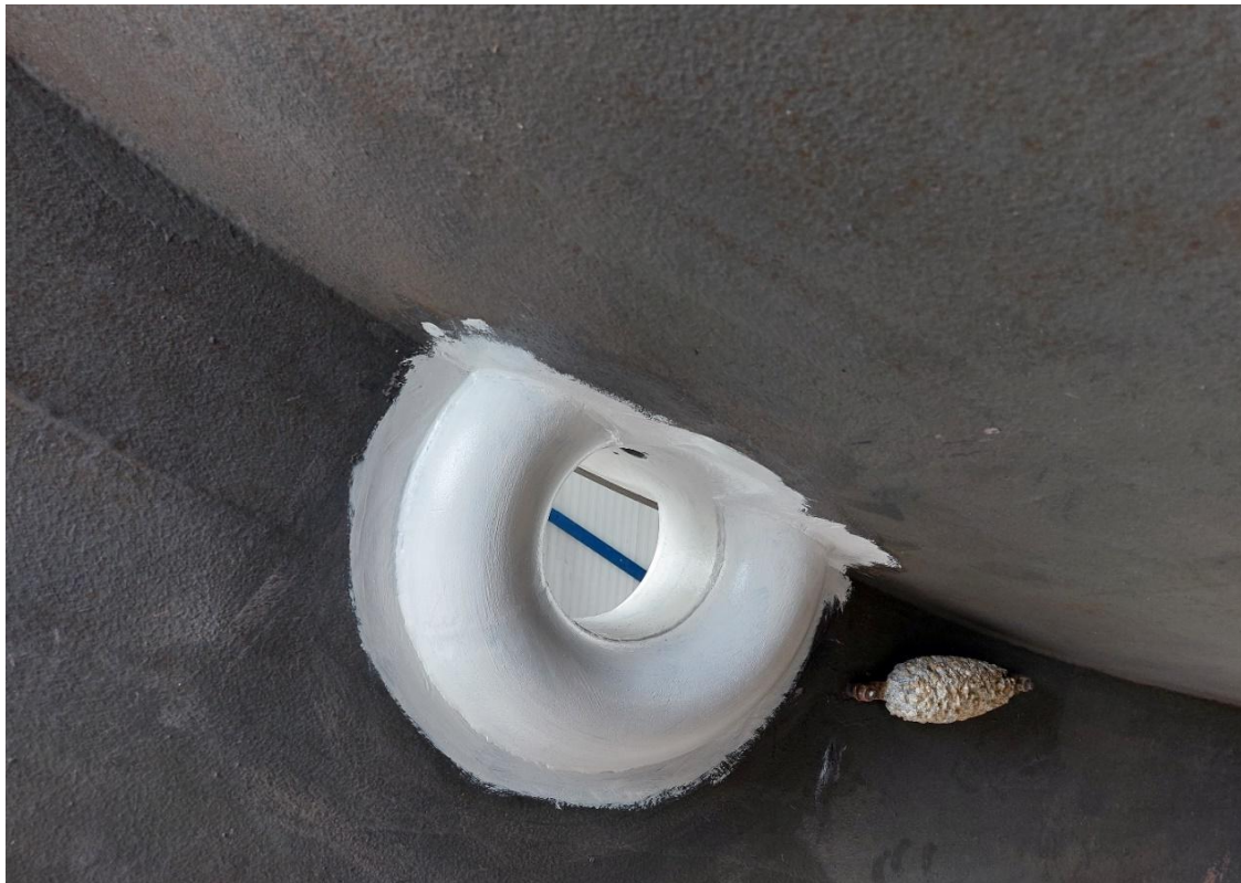
Hindeloopen, 2025. Fraaie constructie voor inbouw van een boegschroef op een Lemsteraak bij scheepswerf Blom. (Foto: DH)
