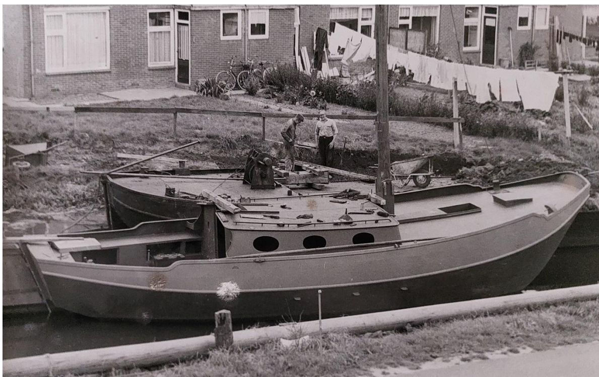
Foto boven: de zeeschouw met doorgetrokken roef onder zeil. Foto onder: Het casco van nog een zeeschouw, maar nu met ovale patrijspooten en de roef achter de mast.
