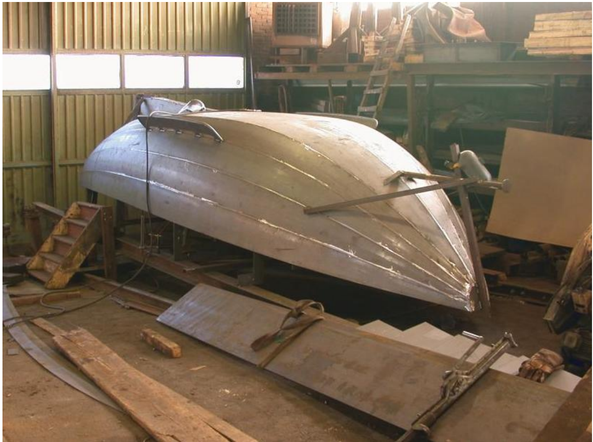
Een stalen rondspantvlet van bijna 7 meter, naar eigen ontwerp Blom.
