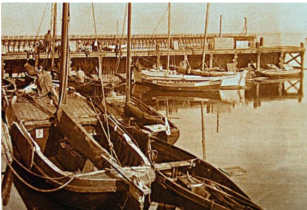
Hindelooper haven in 1933, direct na de afsluiting van de Zuiderzee. De hoge steigers en bekistingen zijn in later jaren afgebroken.
