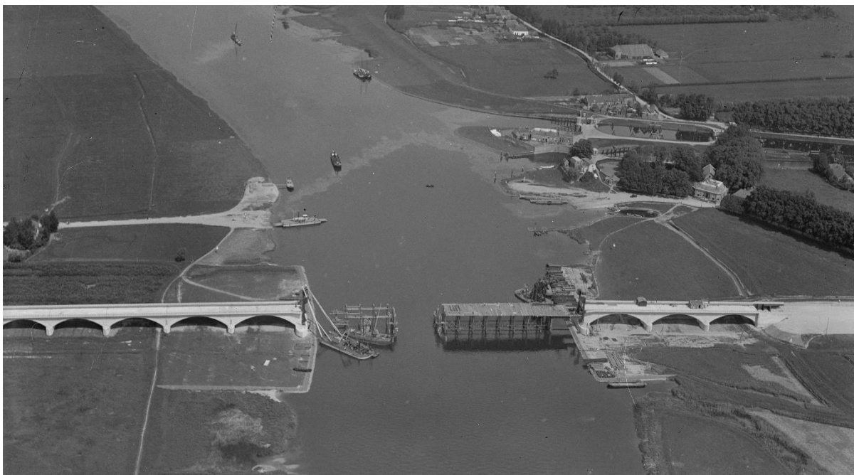
Zwolle, aanleg van de spoorbrug ten zuiden van de sluisen van het Katerveer.
