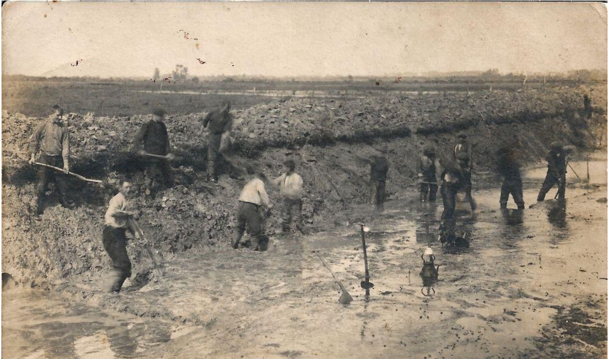
Graven van het Polderhoofdkanaal tussen Nijbeets en De Feanhoop, wat nodig was om het uitgeveende laagveengebied bij Nijbeets weer bewoonbaar te maken en als polder in te kunnen richten voor de landbouw.
