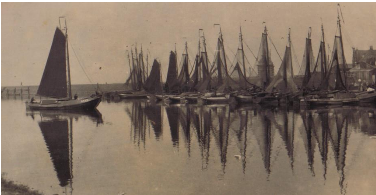
De Vluchthaven van De Lemmer, waar de visserij lag, buiten de sluis.
