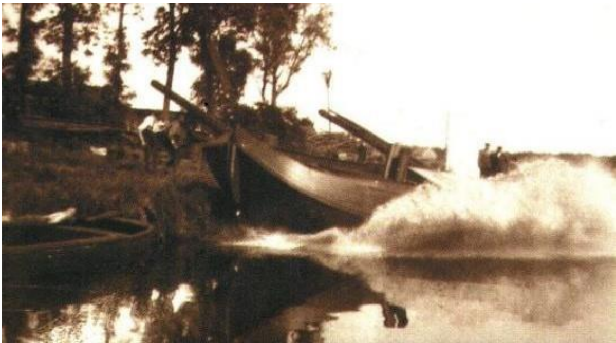
Drachten, Buitenstvallaat. Een pas gebouwd skûtsje glijdt over twee balken het water in.
