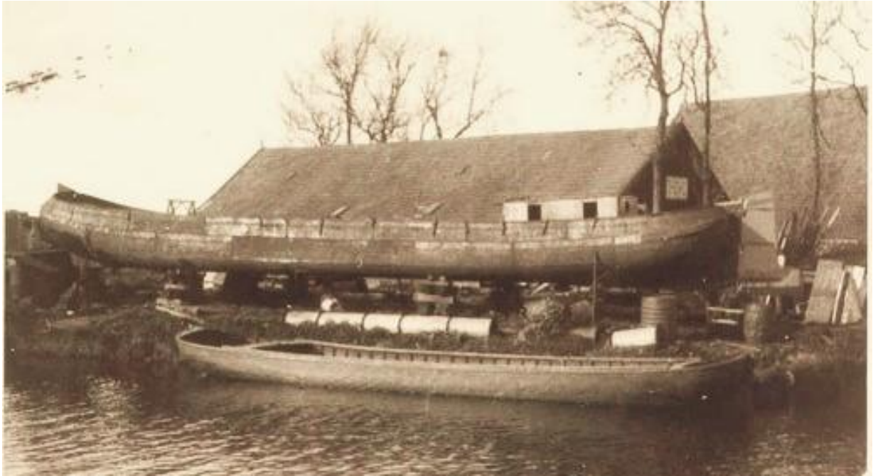
Drachten, buurtschap het Buitenstvallaat. Een skûtsje in aanbouw bij Van der Werff.
