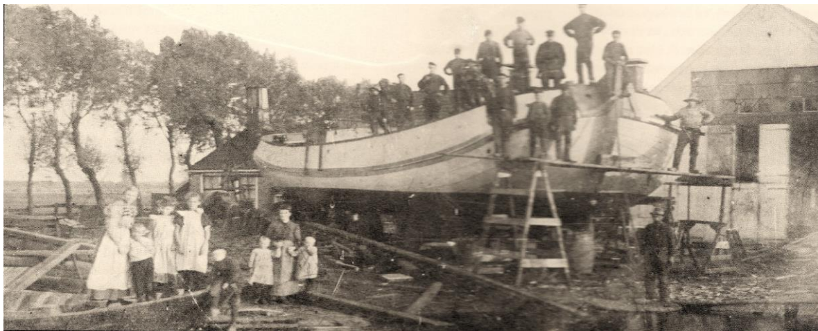
Drachten, ijzeren scheepsbouw aan de Langewijk. Van een grote tjalk is het casco gereed.
