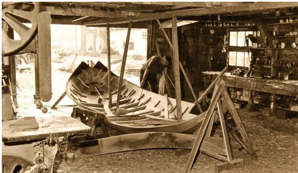
Bouw van een houten tjotter bij Berend de Jong in Heeg.
