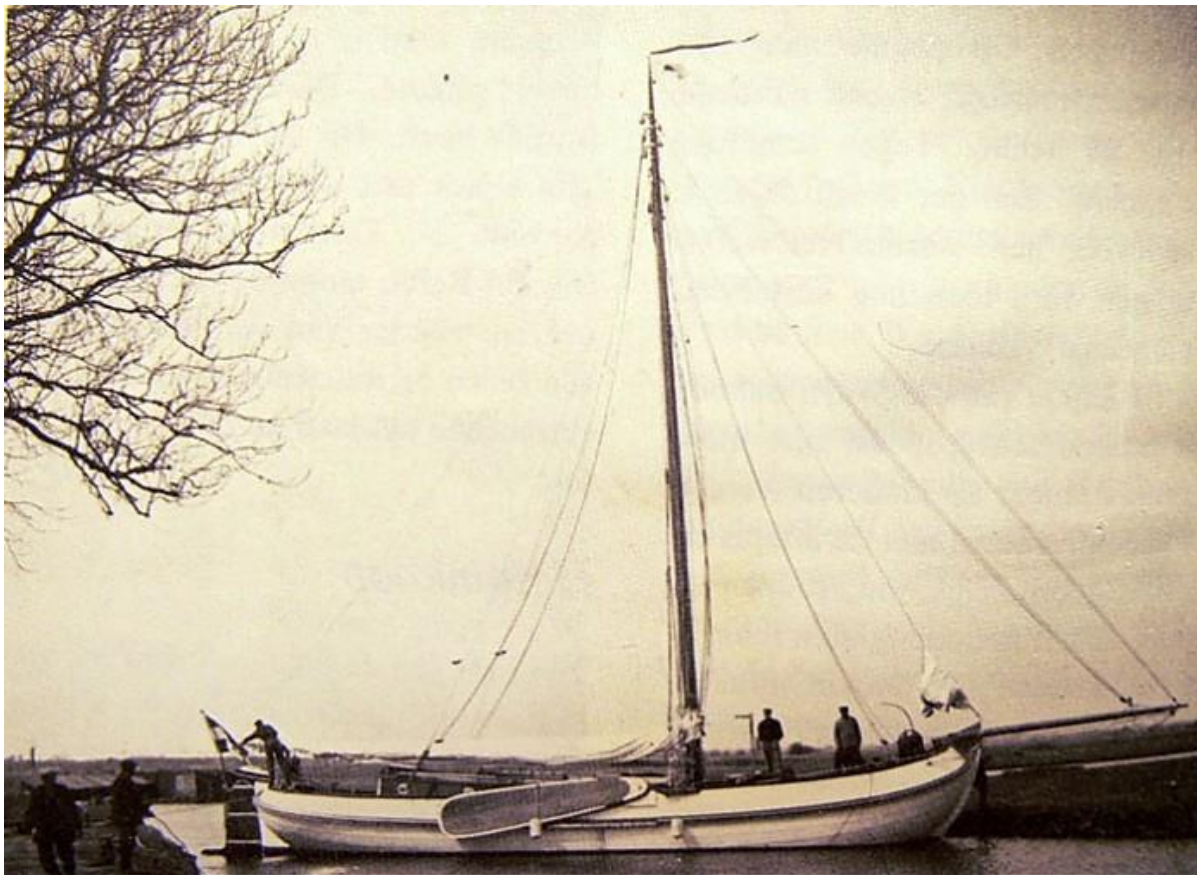
Buitenvallaat, 1917. De boeieraak 'Marva' direct na de tewaterlating. Dit jacht is het meest luxe schip dat Jan Oebeles heeft gebouwd. Het is 17.50 meter lang en ontworpen door de bekende ontwerper van dit type schepen: Dick Zijlstra. Op dit moment vaart deze aak onder de naam 'De brave Hendrik'. (Foto: collectie fam. Van der Werff)
