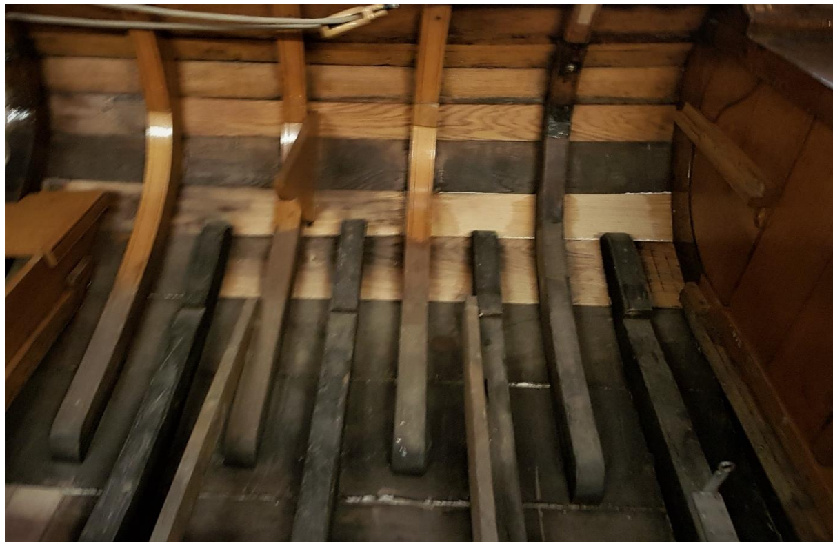
Workum, 2020. De binnenzijde van de Wâldfûgel onder de buikdelling. Hout dat kan ademen. Het meeste hout is in die honderd jaar al eens vervangen door nieuw. (Foto: Dirk Huizinga)
