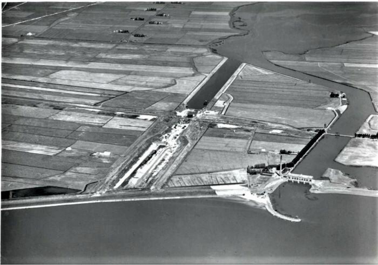
De Lemmer, 1949. Aanleg van de Prinses Margrietsluizen ten westen van het ir. Woudagemaal.
