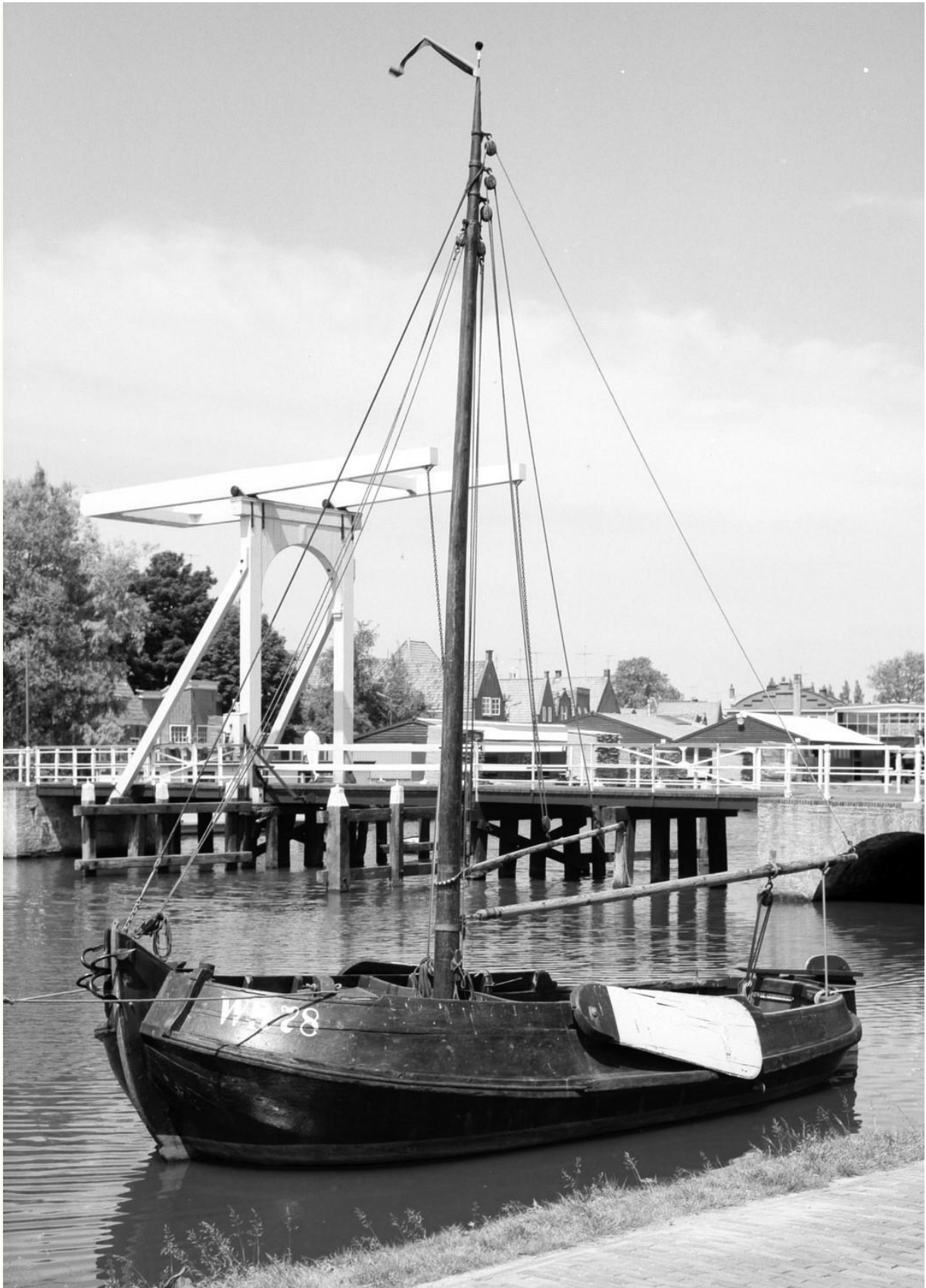
Enkhuizen, 1965. De Wieringer bol WR 78 als aanwinst van het Zuiderzeemuseum. Deze bol is in 1902 bij Lastdrager in Enkhuizen gebouwd. Voor hoog opgeboeid en zonder slemphouten bij de kluisborden. De korte botteloef die vaak wordt genoemd, ontbreekt hier..
