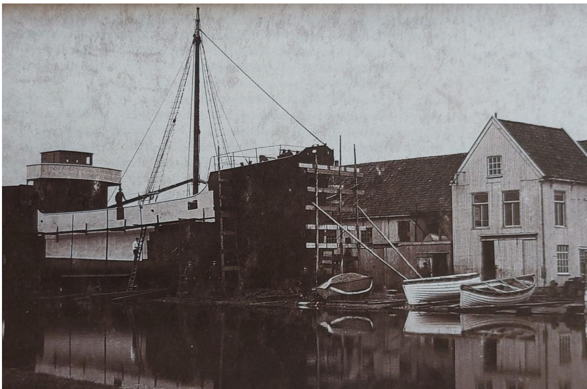
Workum, binnen de sluis. Omstreeks 1916. Foto vanaf de belling van de houtwerf De Hoop van de ijzerwerf van Zwolsman met een coaster in aanbouw. (Foto: FSM, Sneek)
